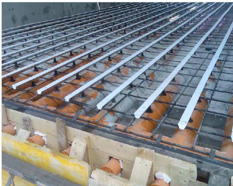
Figura 21 - Particolare della messa in opera del pavimento insufflato delle biocelle.
